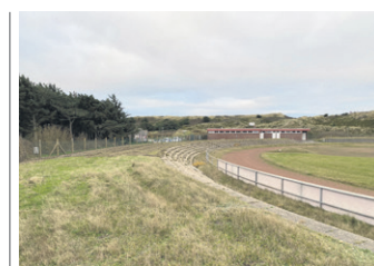
Sylt-Stadion skal rives ned, nu er arbejdet blevet skudt i gang. Foto: Sild Kommune
