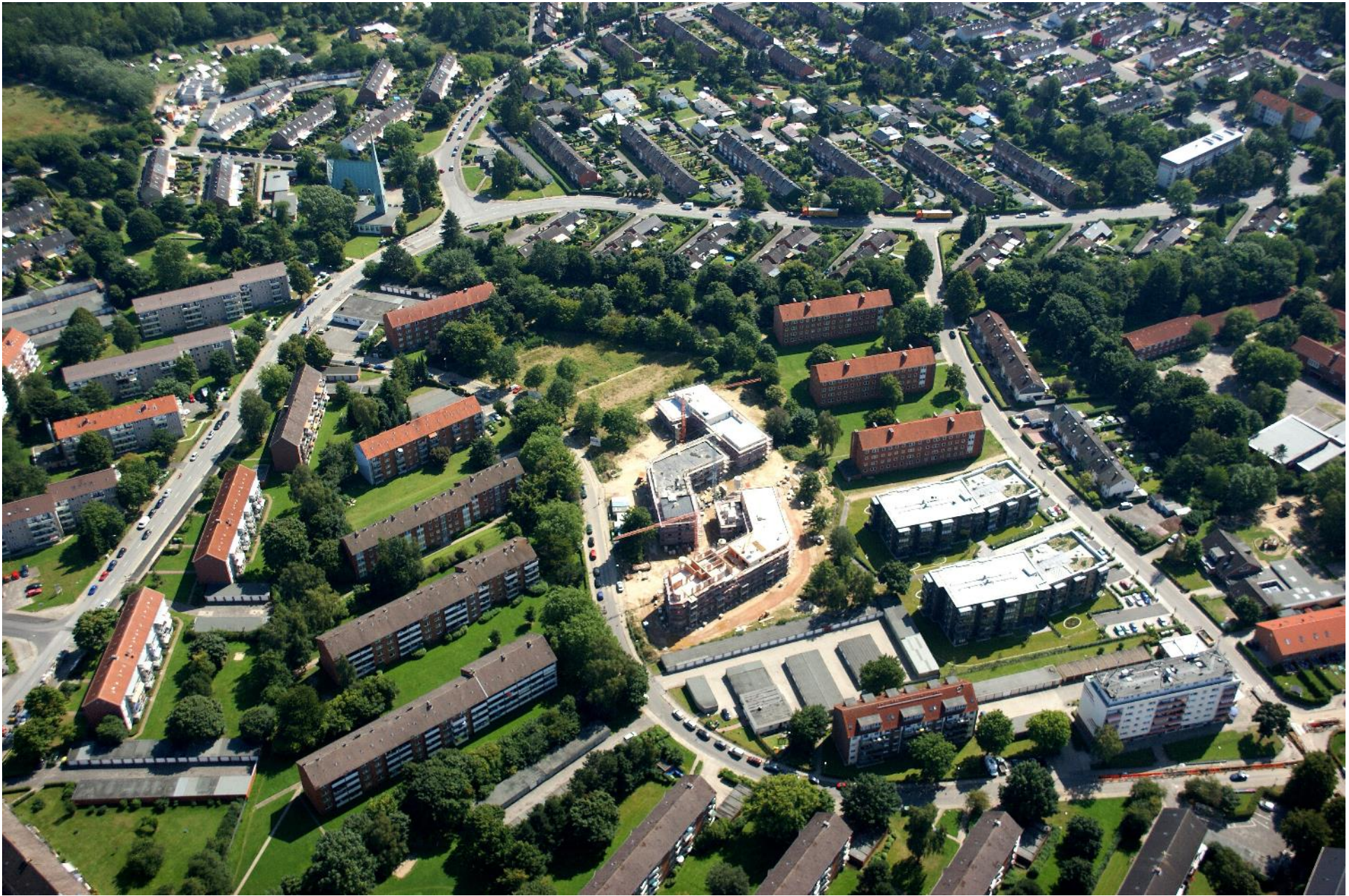
Neubau nach Abbruch im Roten Hahn (Zwischenstand)
