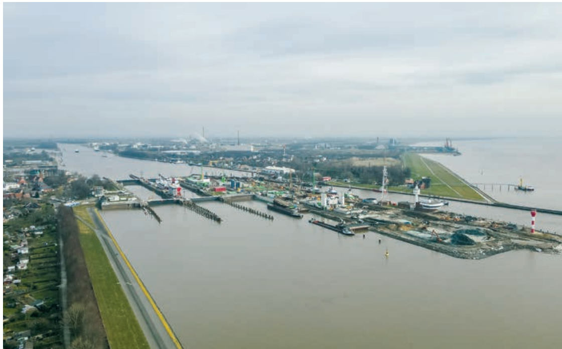
Der Hafen von Brunsbüttel: Künftiger Standort für ein LNG-Terminal (Liquified Natural Gas)
