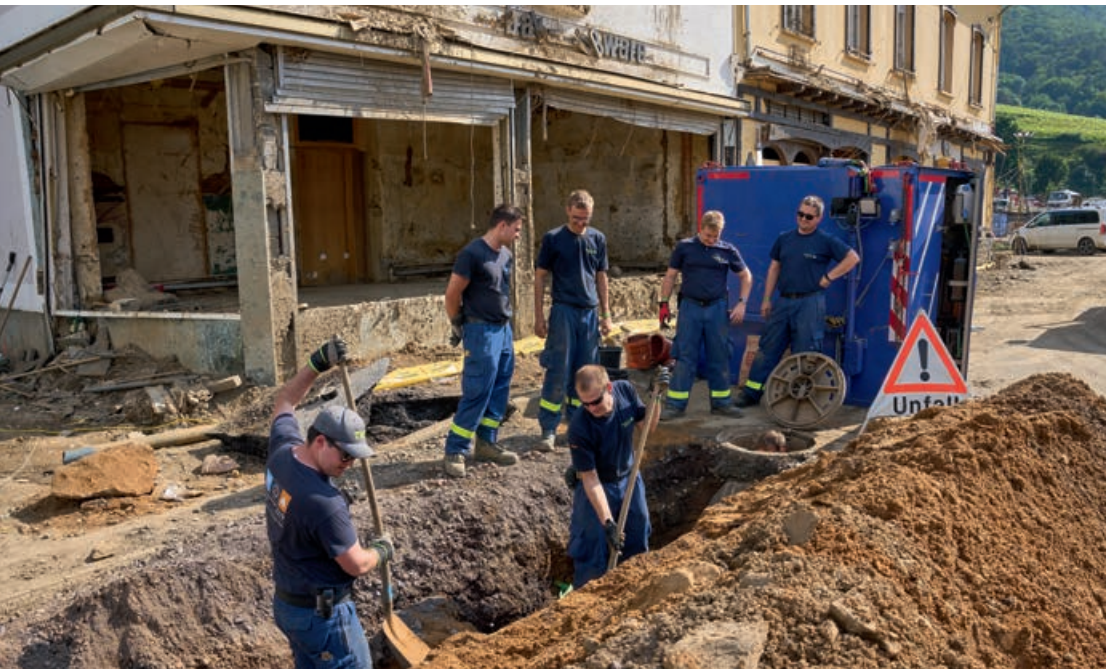
Mayschoß, Rheinland-Pfalz, Anfang September: THW-Helfer bereiten die Reparatur von Abwasserleitungen vor. Im Flutgebiet an der Ahr wurde die Kanalisation in weiten Teilen zerstört.
