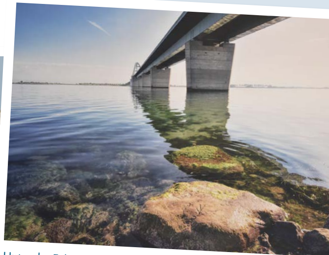
Unter der Fehmarnsundbrücke
