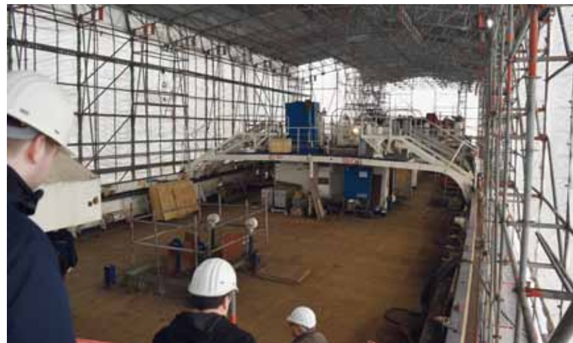
Eingerüstet und entkernt: die „Gorch Fock“ in der Werft
