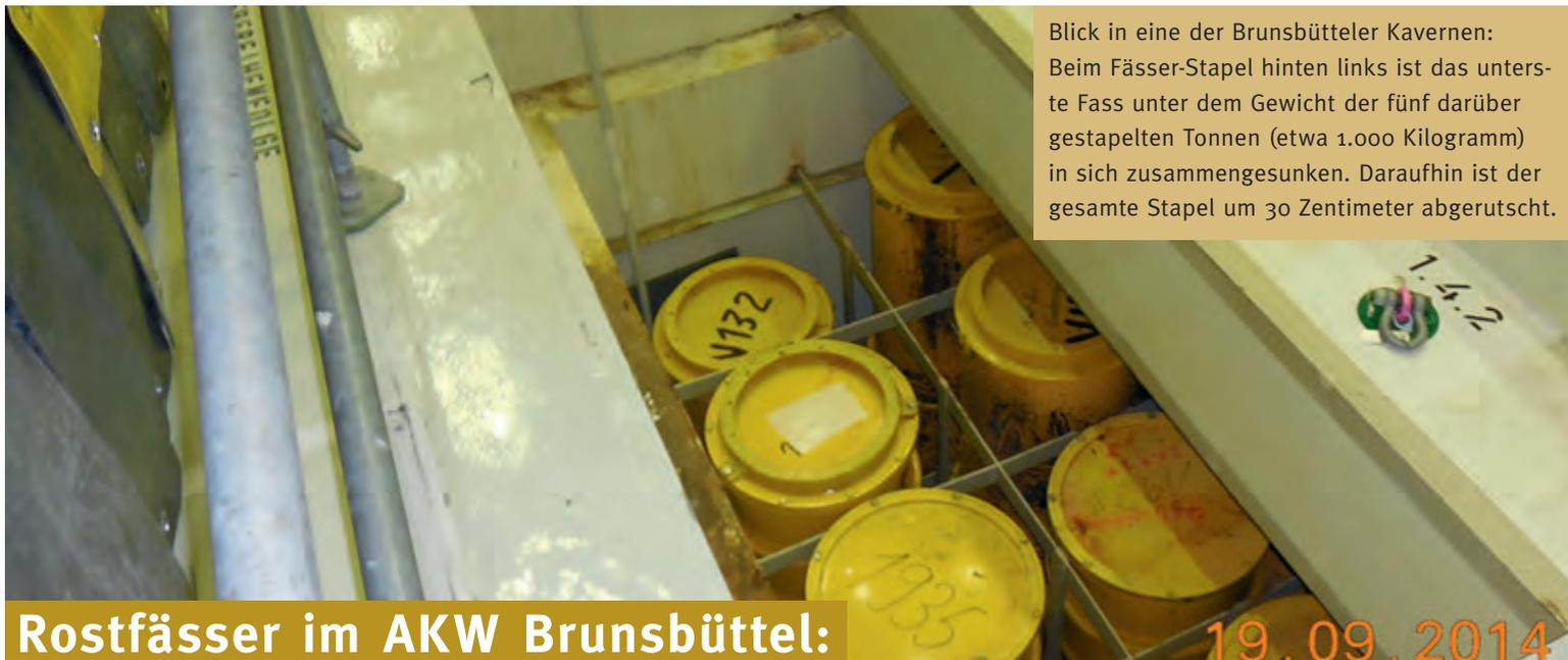
Blick in eine der Brunsbütteler Kavernen: Beim Fässer-Stapel hinten links ist das unterste Fass unter dem Gewicht der fünf darüber gestapelten Tonnen (etwa 1.000 Kilogramm) in sich zusammengesunken. Daraufhin ist der gesamte Stapel um 30 Zentimeter abgerutscht.
